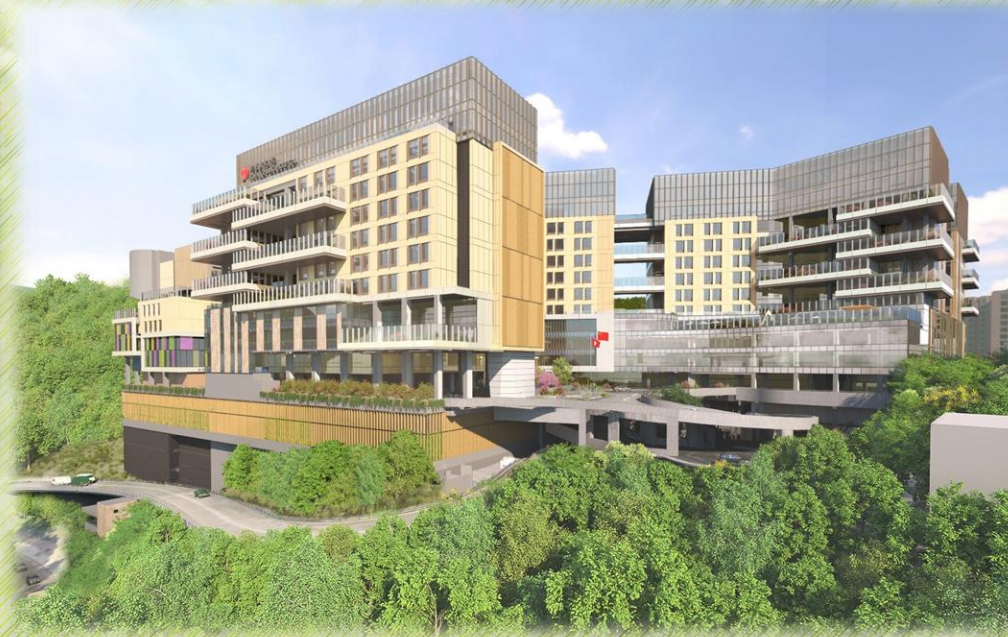
SS G502 – 设计及建造新界葵涌医院道3-15 号 葵涌医院重建工程(第二期)
